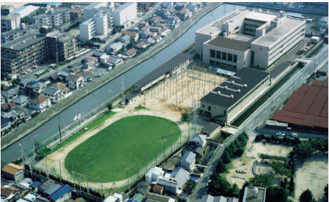
現校舎(1981年竣工)
