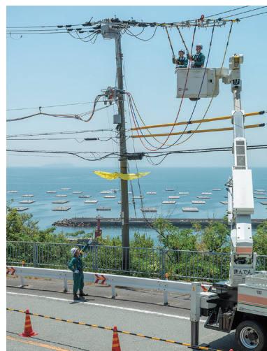
活線振分工具を使用した無停電工事 (兵庫)
