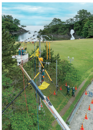
活線振分工具を使用した 無停電による設備改修工事(福井)
