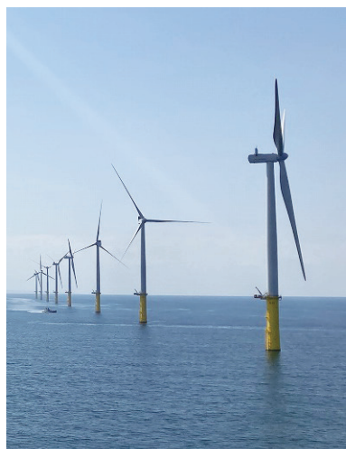
秋田港・能代港洋上風力発電所(秋田)
