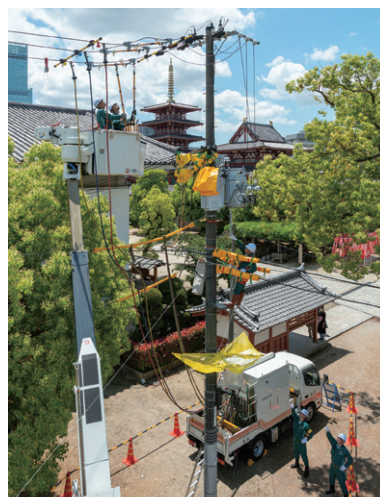
工事用変圧器車を使用した 間接活線工法による無停電工事(大阪)
