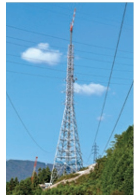
須原大井線No.31~No.40 (木曾幹線併架)改良工事(長野)
