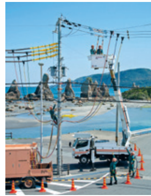
工事用変圧器車を使用した 間接活線工法による無停電工事(和歌山)
