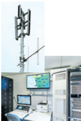
御坊市デジタル防災行政無線施設 整備工事(和歌山)
