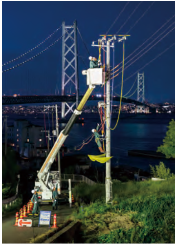
間接活線工法による無停電工事 (兵庫)
