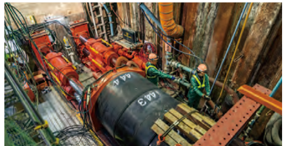
地中管路新設工事 (兵庫)
