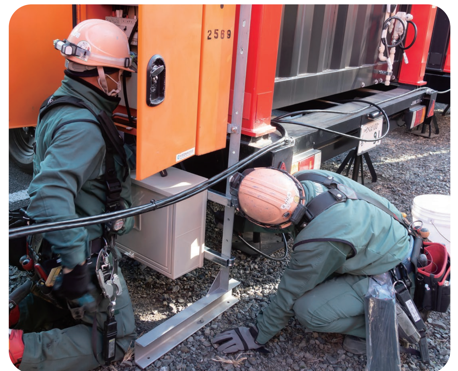
有事における仮設置作業
