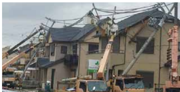
被害の大きい地域では複数の高所作業車を集結させ復旧作業を進めた
