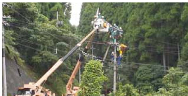
山間部での復旧作業
