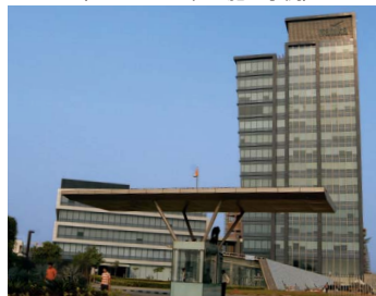
ヴァチカグルガオンタワー1新築電気設備工事
