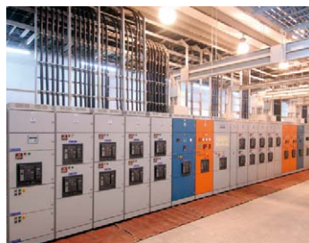
ヴァチカビジネスセンター新築電気設備工事
