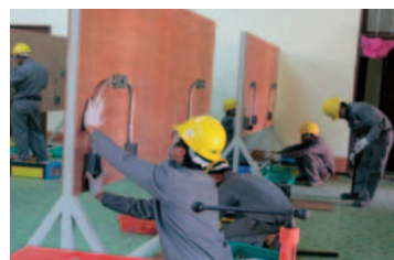
一般電気工事コースの配管・配線実習
